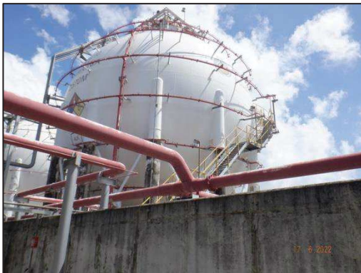
รูปที่ 3-41 ระบบดับเพลิงบริเวณถังแอมโมเนียและโพรเพน
