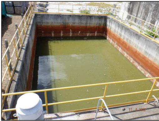
บ่อรวบรวมน้ำฝนปนเปื้อนบริเวณลานล้าง
