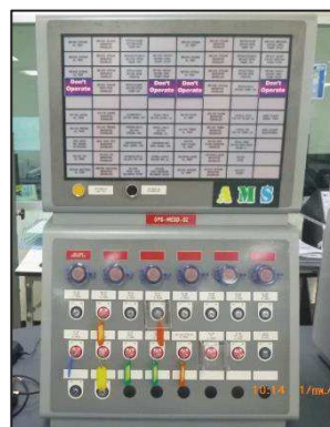
ตัวอย่าง Emergency shutdown system – ESD Control Panel ของ MMA Plant
