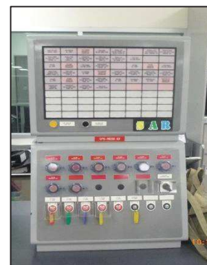
ตัวอย่าง Emergency shutdown system – ESD Control Panel ของ MMA Plant
