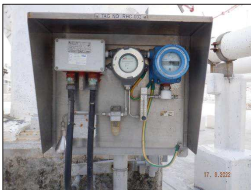
Gas Detector บริเวณถังเก็บกักไอพอร์เฟน
