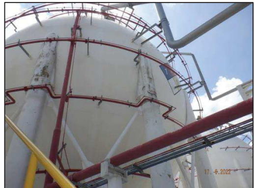
รูปที่ 3-41 ระบบดับเพลิงบริเวณถังแอมโมเนียและโพรเพน
