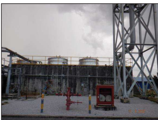
รูปที่ 3-42 บ่อรวบรวมและปรับสภาพ สารละลายแอมโมเนียมไฮดรอกไซด์ที่หกั่วไหล
