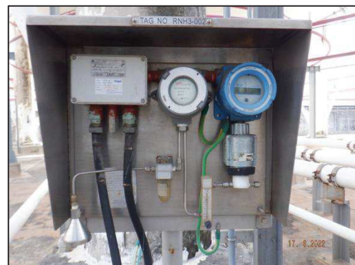
Gas Detector บริเวณถังเก็บกักแอมโมเนีย
