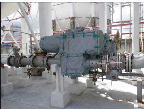
รูปที่ 3-35 Block Valve บริเวณท่อขนส่ง
