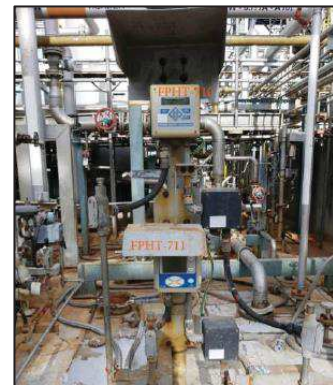
เครื่องตรวจวัด pH และ Conductivity แบบอัตโนมัติ บริเวณบ่อฟักน้ำทิ้งจากหน่วยผลิตกรดซัลฟูริก (SAR)
