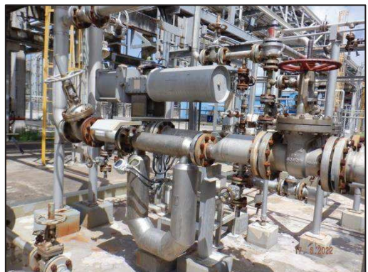
รูปที่ 3-35 Block Valve บริเวณท่อขนส่ง
