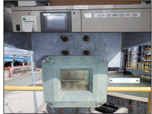
เครื่องตรวจวัด pH และ COD แบบอัตโนมัติ บริเวณบ่อฟักน้ำทิ้งจากระบบบำบัดน้ำเสีย (RO-BIO)
